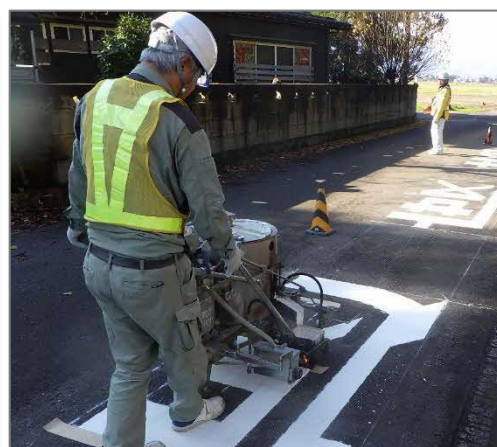
路面標示工事（文字）
