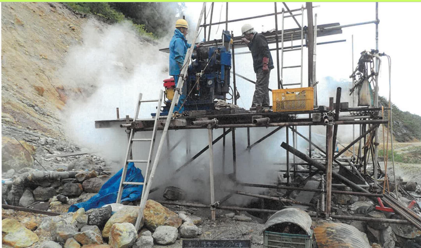
地熱噴気確保作業（ボーリング事業者による作業時には、手伝い作業あり）
