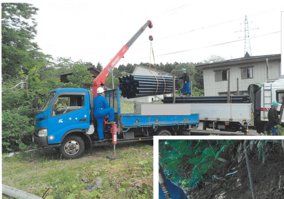
温泉供給本管の納入 （源泉から送湯用の温泉供給 本管125ミリの管）
