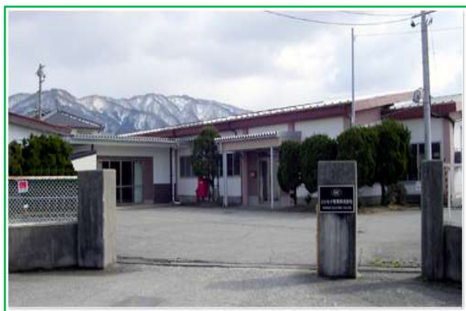
本社事務所・工場外観
