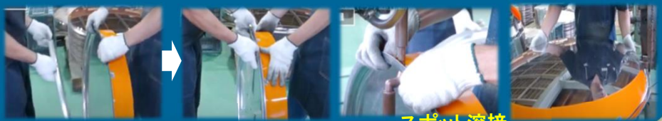
スポット溶接
