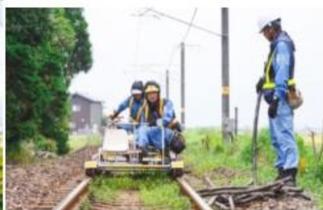
【鉄道関連工事】
