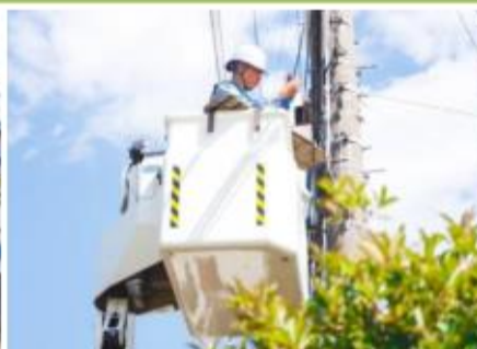
【通信設備工事】
