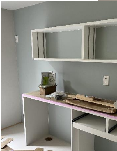
【キッチン施工】
