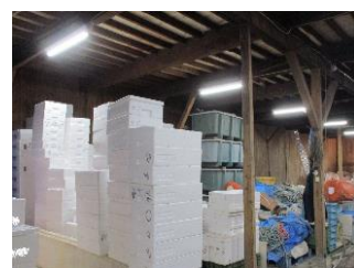
倉庫内の様子
