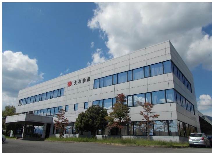
事務所棟 外観
