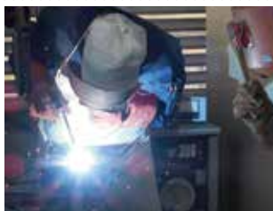
被覆アーク 溶接作業
