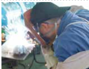
半自動アーク 溶接作業
