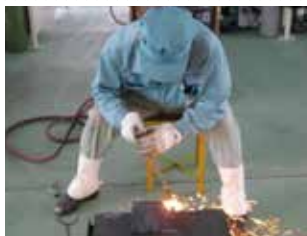
ガス切断作業
