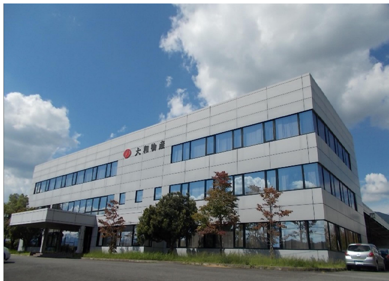
事務所棟 外観
