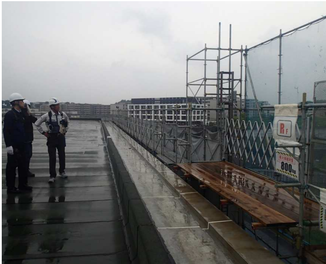
足場や通路、屋上等における適切な墜落防止対策の実施状況を視察する様子
