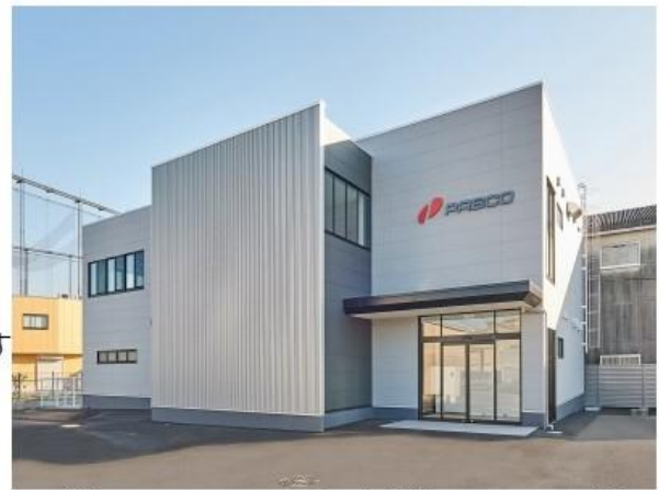
従業員のための厚生棟（食堂・シャワー室）
