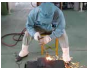
ガス切断作業
