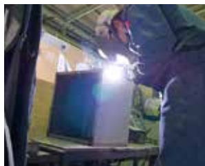
配電ボックスの溶接作業
