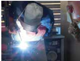
被覆アーク 溶接作業
