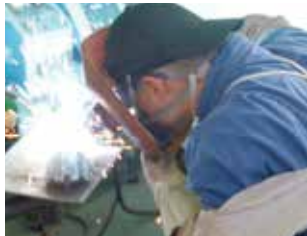
半自動アーク 溶接作業
