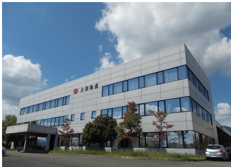
事務所棟 外観
