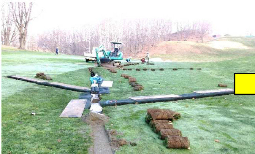
従来の排水対策（暗渠排水工事）
