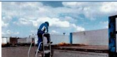
墜落・転落防止：昇降台の導入
