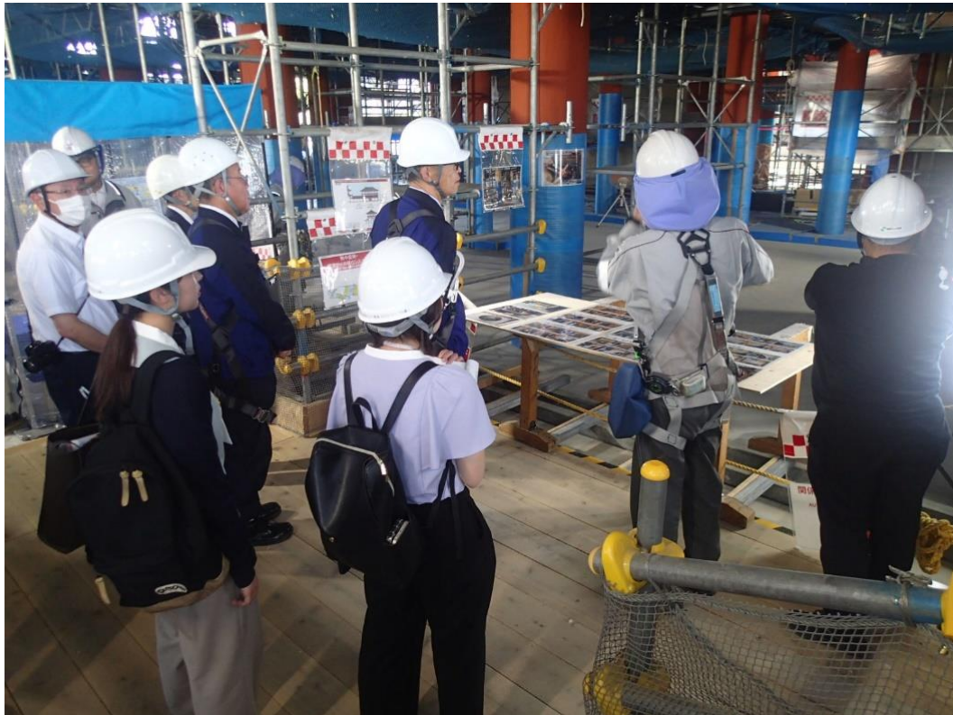
工事現場の安全対策や熱中症の防止対策等について、工事担当者から説明を受けている様子。
