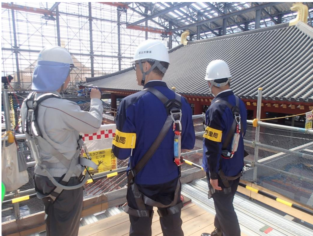
足場や通路等現場全体に高水準な安全対策が実施されていることを視察しました。
