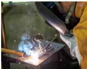
被覆アーク溶接作業
