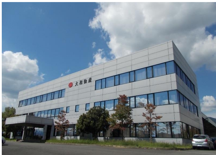
事務所棟 外観
