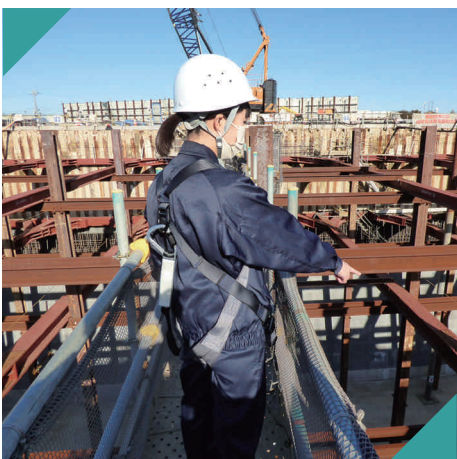
▲ 建設現場での安全確認
