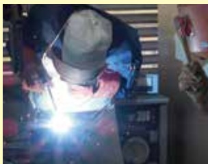
被覆アーク溶接作業
