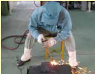
ガス切断作業
