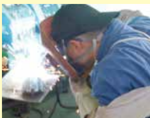
半自動アーク溶接作業
