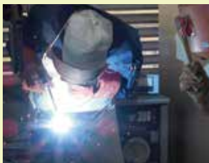
被覆アーク 溶接作業
