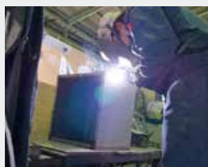
配電ボックスの溶接作業
