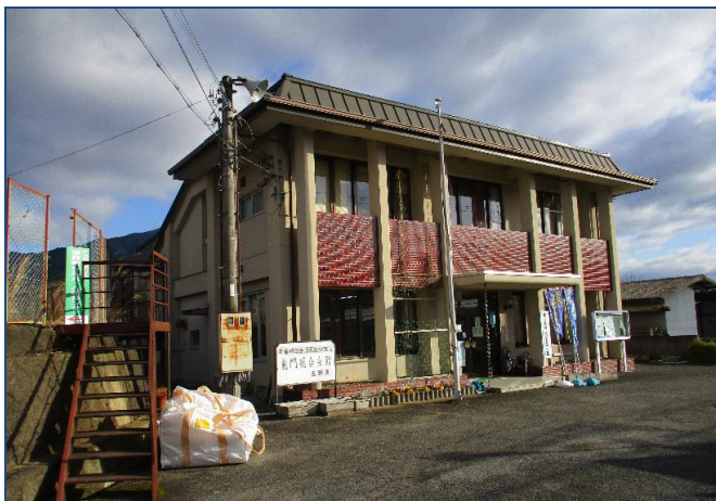
事務所建物外装
