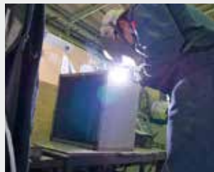
配電ボックスの溶接作業
