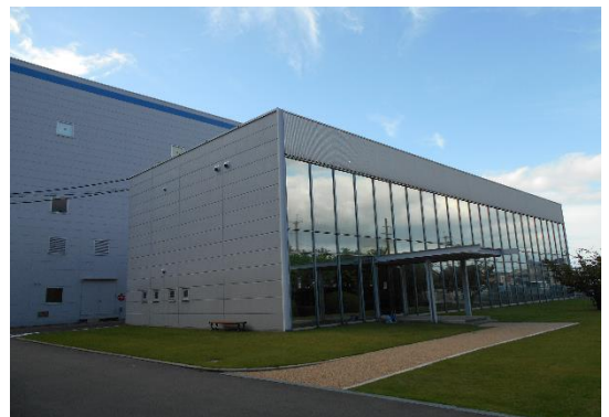
クオリカプス株式会社 本社工場(3号館)
