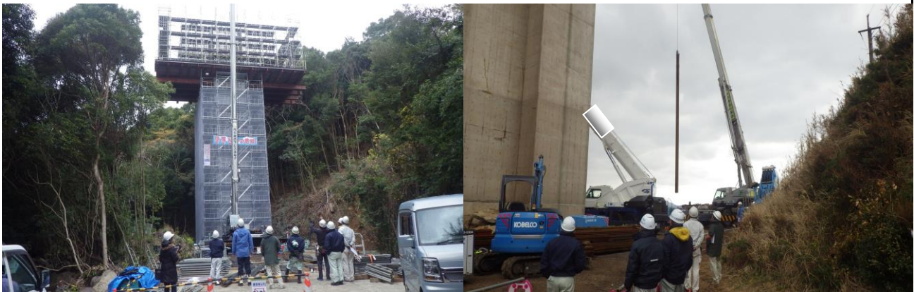
道路改良工事(橋梁上部工)
