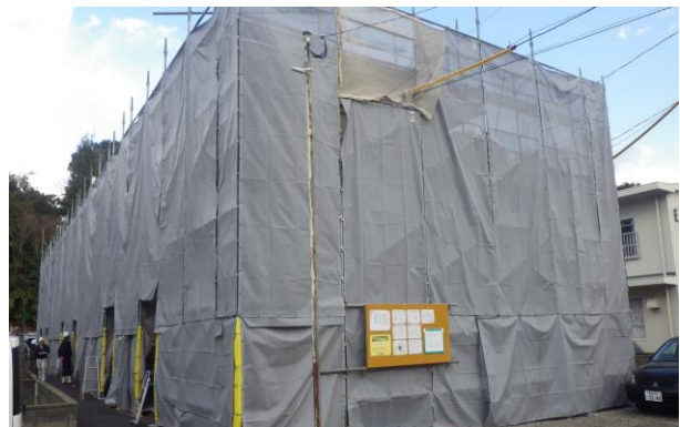
団地屋根・外壁改修工事
