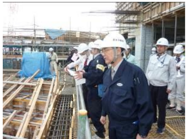
(安全パトロールの様子)
