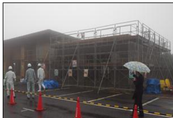
施設増築工事現場
