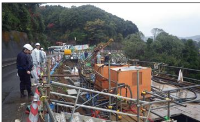
道路改良工事現場
