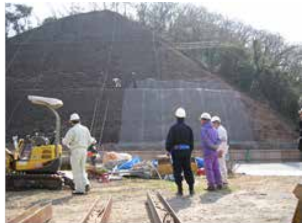
安全帯の確実な使用を確認
