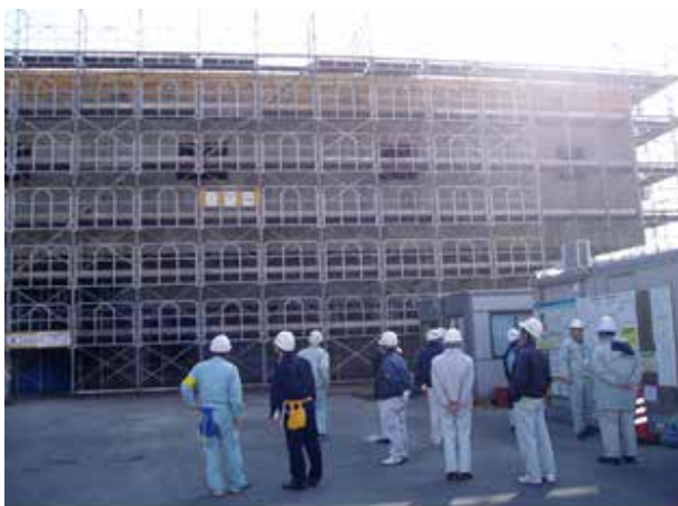
墜落防止、崩壊防止等について指導
