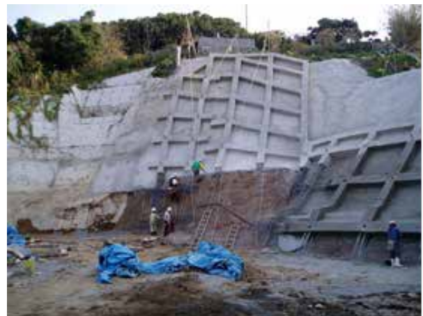
墜落防止、地山崩壊による危険防止について指導
