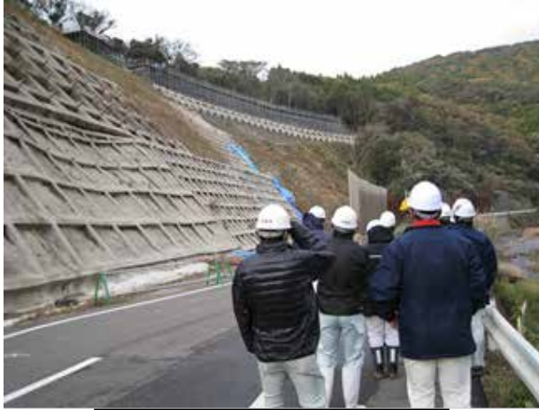
足場の崩壊防止等について指
