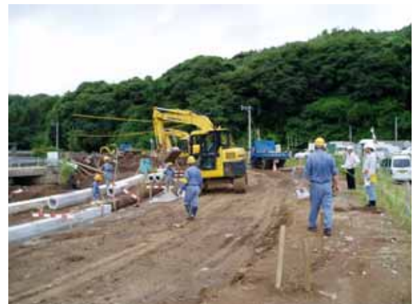
（重量物設置作業を確認）
