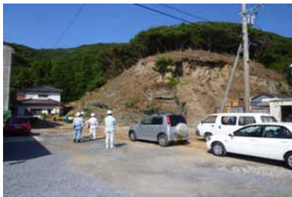
(掘削作業時の注意事項を指導)
