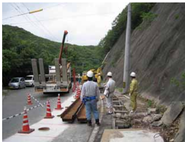
（荷吊り作業を注視）
