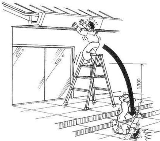
事務所入口の看板を交換するため、高さ 1.8m の脚立にまたがり撤去作業中、脚立より転落し頭部を強打。
