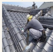
かわらぶき工事
