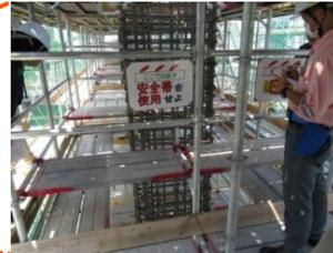
(左) 鉄筋で美しく組まれた柱部分。このあと型枠、コンクリート打設を経て高架橋の柱となる。熱心にメモを取る参加者の方。
