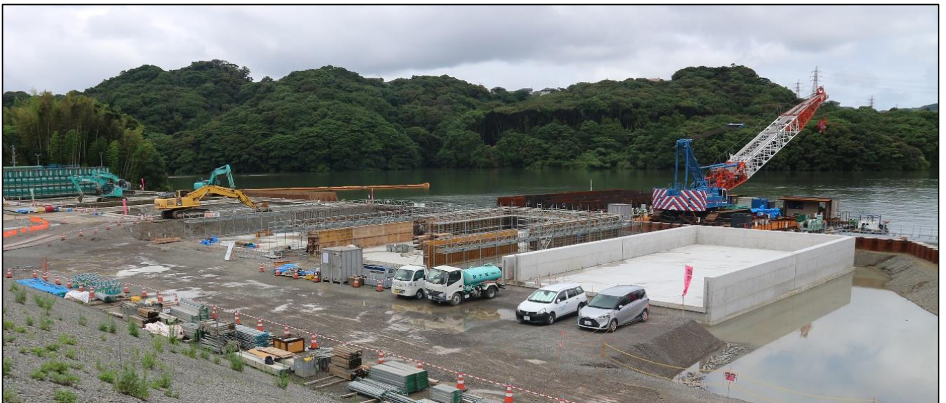
【写真 2】浦上ダム建設工事現場の様子
