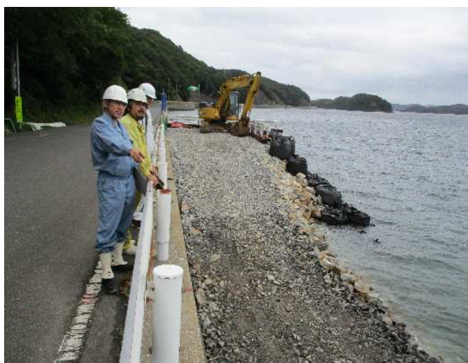
路肩から転落する危険のある箇所を示し、 現場代理人から安全対策の説明を受ける 俵署長（写真手前）の様子
