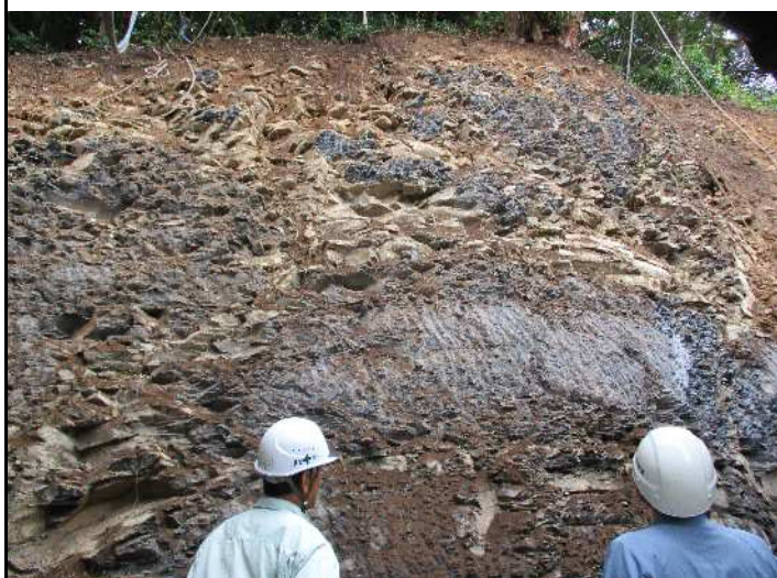
法面作業における安全対策を確認する 俵署長（写真右側）の様子
