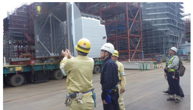
九州電力(株)松浦発電所2号機建設工事現場 パトロール風景
