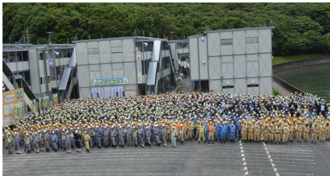
九州電力(株)松浦発電所2号機建設工事風景
