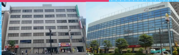
BPOセンター長崎中央(元船町)
