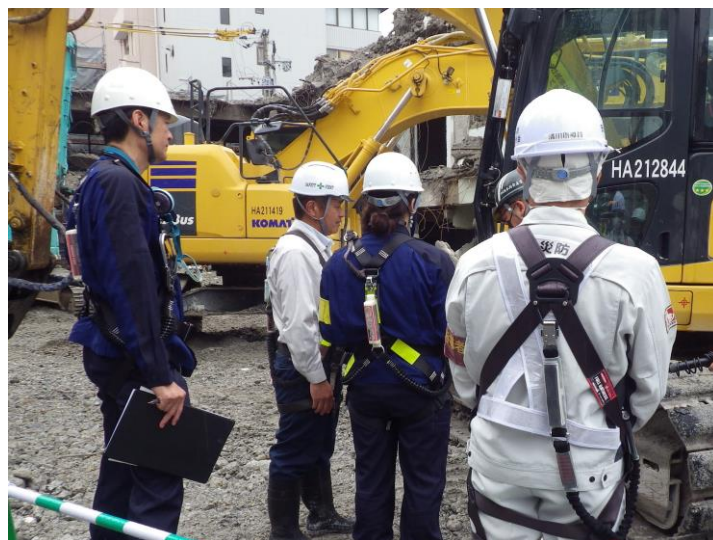
解体用機械の運転資格を確認する長崎労働基準監督署の職員
