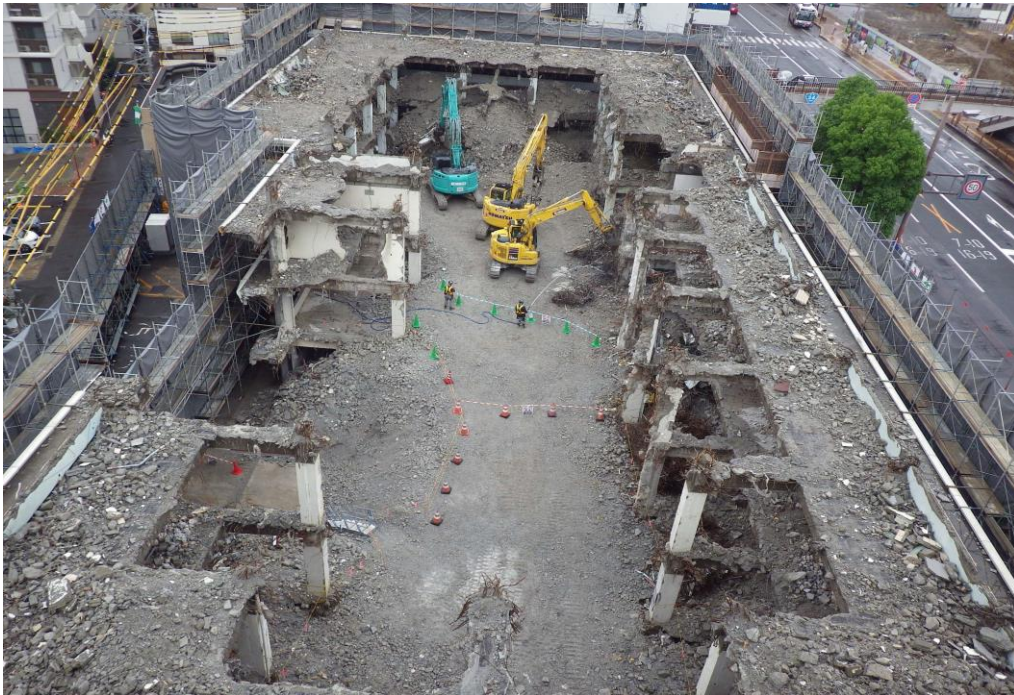
現場の全景を上から撮影したもの
