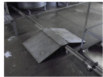
通路上の障害物には、スロープを設置
