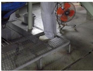
設備の点検のため踏み台を設置
