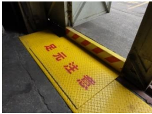
解消できない段差に標識等で注意喚起
