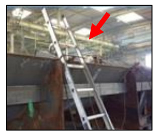
転移・滑動防止のため梯子は固定して使用する。
