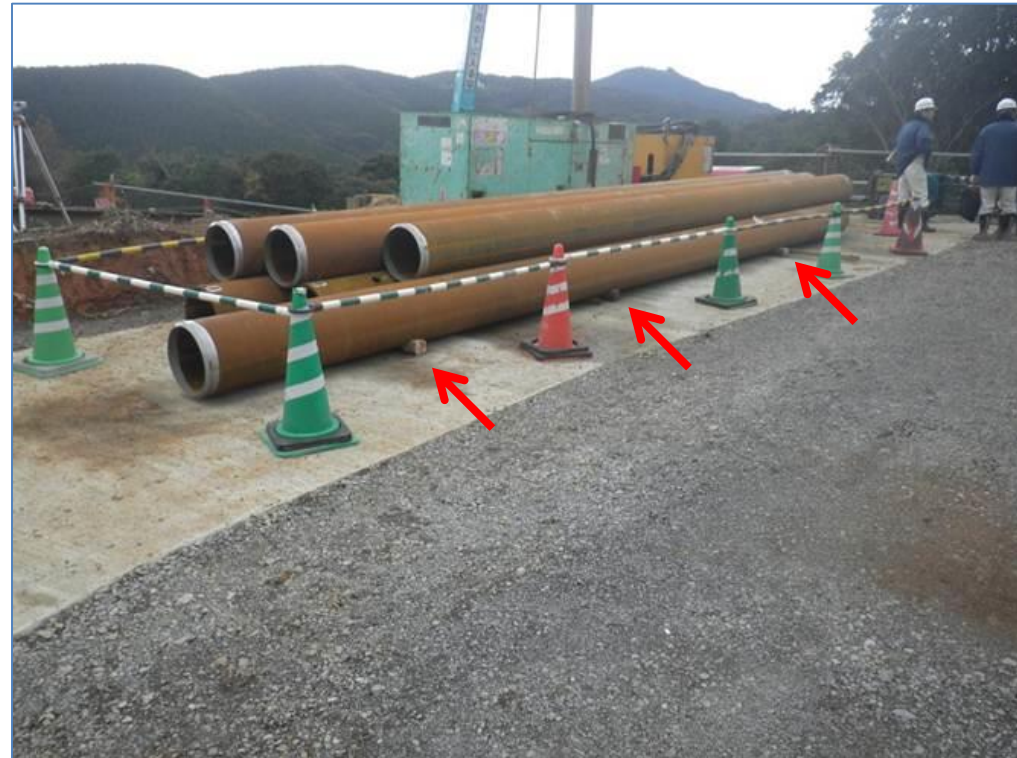
鋼管の転倒防止措置
