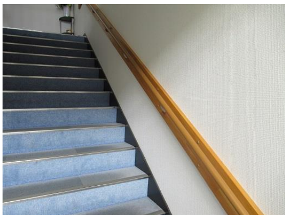
階段に手摺を設置
