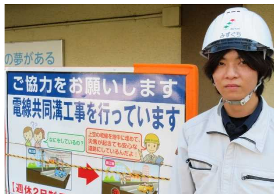
現在ライフラインの整備工事に携わられている水口さん。安全に配慮した夜間作業を行うよう現場管理を行ってられます。
