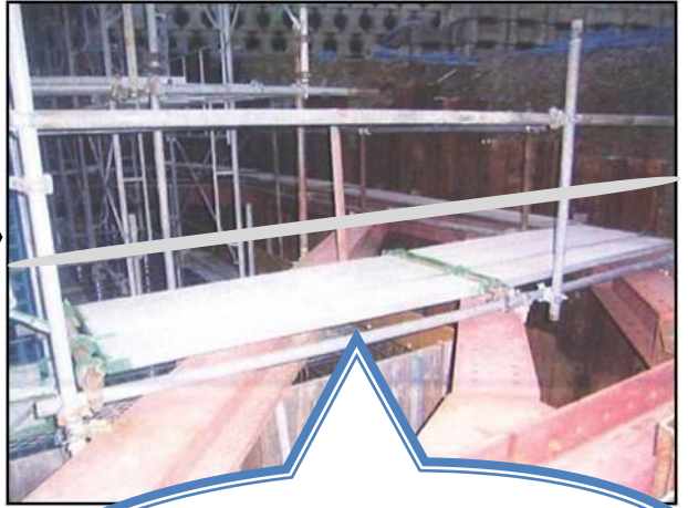
改善後：鉄骨上に作業床を設置
