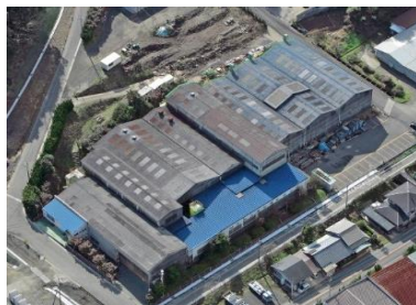
御橋第一防錆工場
