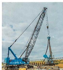
クローラークレーンと全周回転で場所打杭工事をしているところ
