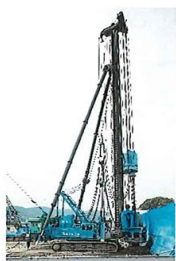
九州最大級の杭打機で杭打ち工事をしているところ
