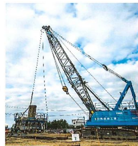
クローラークレーンとクラッシュバイラーで山留工事をしているところ
