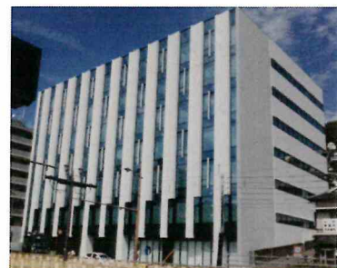
長崎駅前電気ビル
